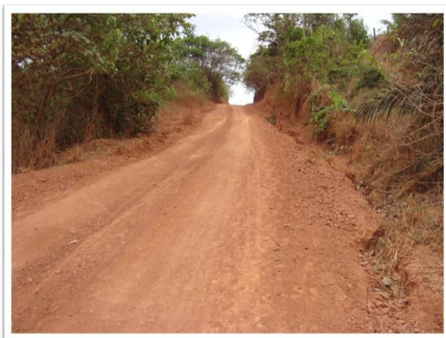
Figura 30 - Formação de processos erosivos em estrada vicinal.
