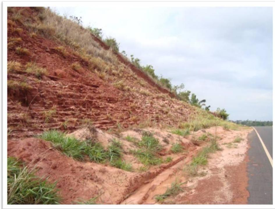
Figura 40 - Erosão na lateral da MA 125.
