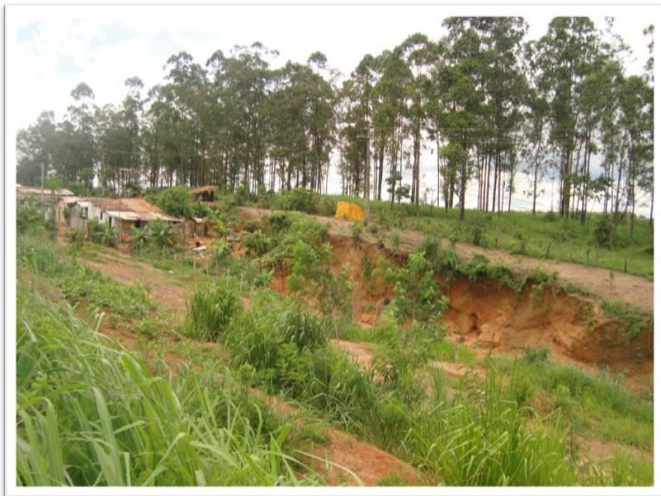
Figura 39 - Erosão na lateral da BR 010.
