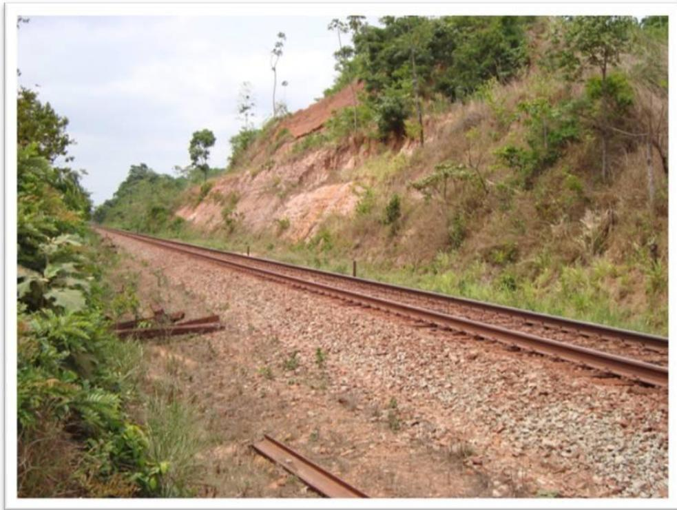
Figura 38 - Rede de ravinas formada em talude exposto nas proximidades da Ferrovia Carajás.
